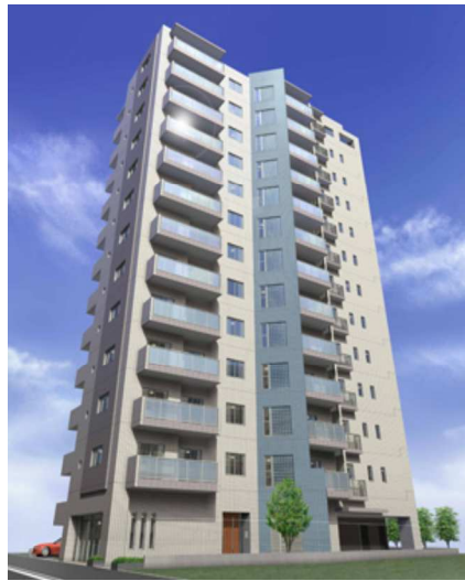
ユーザーので耐震偽装マンション
