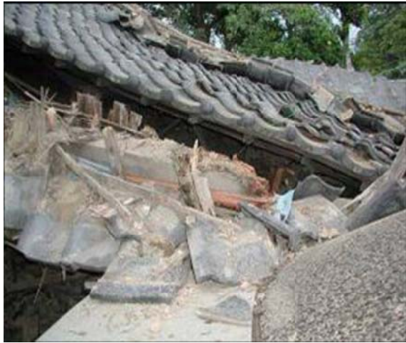
宮城県沖地震で倒壊した加須市の住宅
