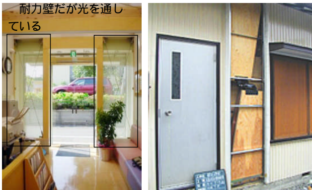
(写真左) ひかりかべ (写真右) GHハイブリッド (耐力壁だが光を通している)
