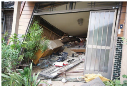
「大地震は当分こないだろう」と中越地震後に簡単な補修のみだったため、今回の地震で倒壊した住宅もあった
