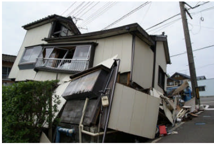
「大地震は当分こないだろう」と中越地震後に簡単な補修のみだったため、今回の地震で倒壊した住宅もあった
